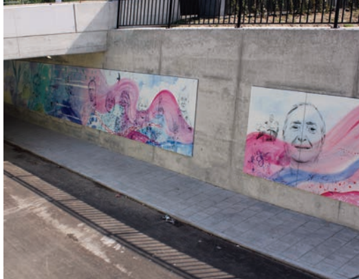
Fietstunnel Rivierenwijk, Deventer
